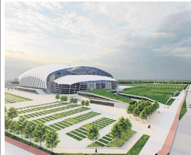
Tak będą wyglądać tereny wokół Enea Stadionu w Poznaniu w najbliższej przyszłości
