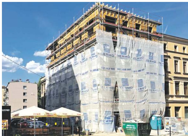
Budynek na razie otaczają rusztowania, ale widać jego nadbudowaną „koronę”
