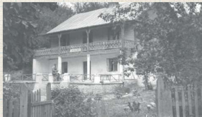
Andriolli w Nałęczowie mieszkał w domu Krawczyńskiego, na obecnej ulicy Poniatowskiego. Elementem zbliżonym stylistycznie do „świdermajera” jest ażurowa balustrada
