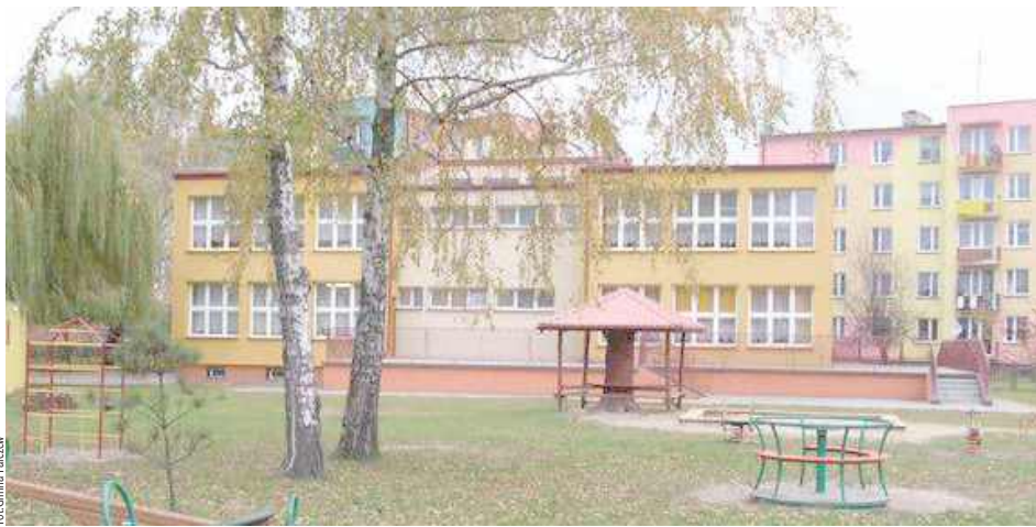
W planie są roboty budowlane w budynku Publicznego Przedszkola nr 2 w Parczewie (całościowa wymiana instalacji elektrycznej, malowanie pomieszczeń, odnowienie elewacji budynku, usunięcie ubytków, malowanie), budowa placu zabaw przy przedszkolu (podłoże poliuretanowe, urządzenia z certyfikatami)
