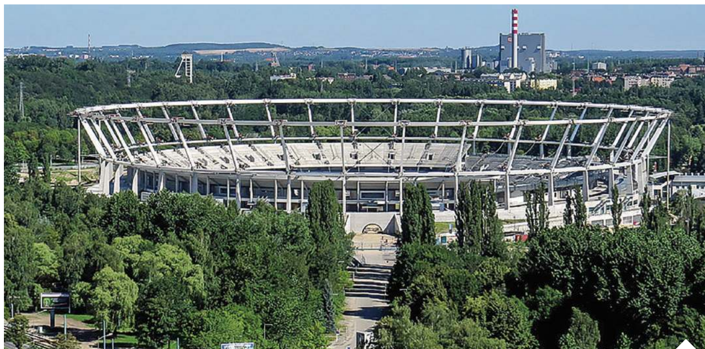
27 lipca 2017 r. decyzją powiatowego inspektora nadzoru budowlanego w Chorzowie uzyskano pozwolenie na użytkowanie rozbudowanej części Stadionu Śląskiego. W ten sposób została zakończona inwestycja mająca status przedsięwzięcia Euro 2012 | fot. Wikipedia/d
