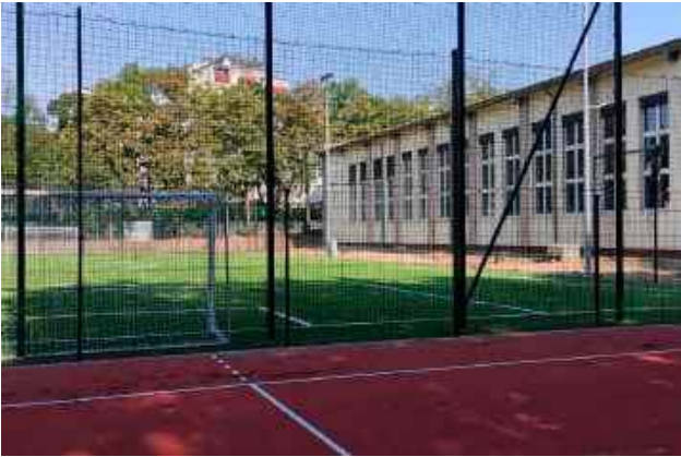
Sala sportowa, o której od lat marzyła społeczność I LO jest praktycznie gotowa. Ma wymiary 44 na 24 metry kwadratowe i powierzchnię 1754 m kw. Kubatura obiektu wynosi około 19 tys. m sześć. Na parterze i kondygnacji podziemnej powstało sześć szatni, dwa magazyny i siłownia. Do tego na piętrze znalazło się miejsce na pięć sal lekcyjnych. Hala jest połączona z budynkiem liceum łącznikiem
