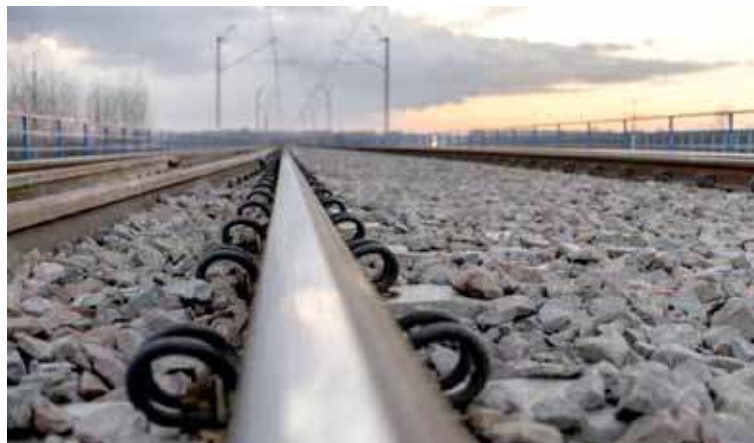
Niebawem rozpoczną się prace na 34-kilometrowym odcinku od stacji Choszczno do stacji Stargard
