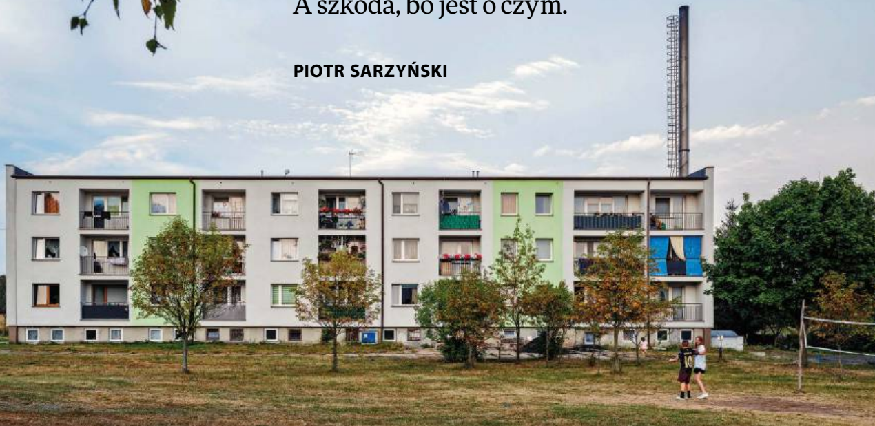
Blok na osiedlu pracowniczym byłego PGR w Babsku
