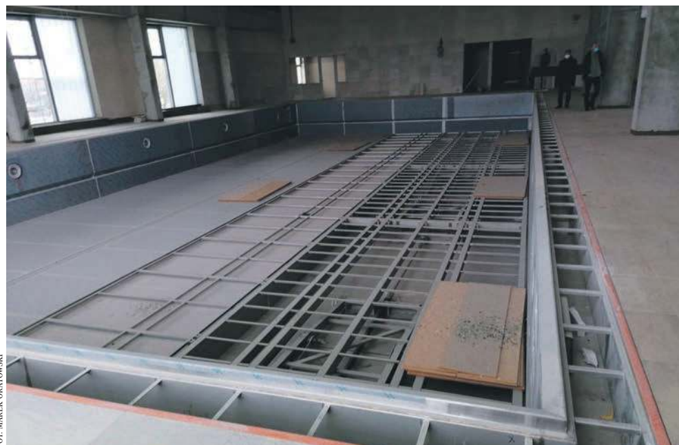
Główna niecka z mechanizmem podnoszenia dna. Video można obejrzeć na www.przelom.pl
