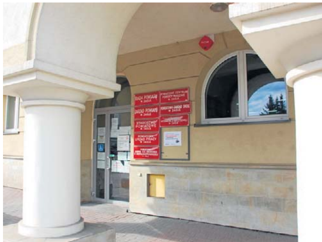
Powiatowy Urząd Pracy znajduje się w budynku Starostwa Powiatowego w Jasle
