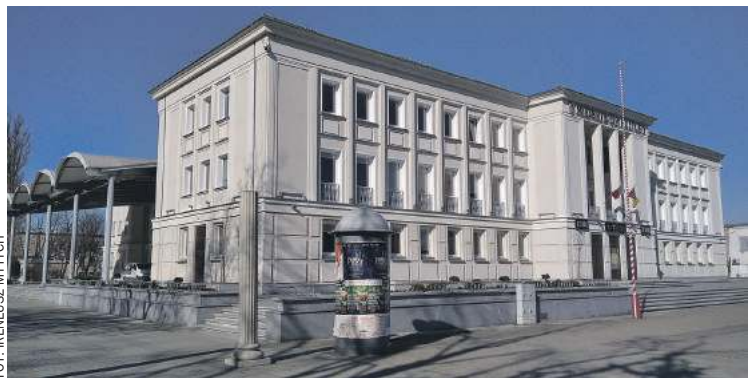
W poprzednich latach remontowane było zewnętrzne Miejskiego Domu Kultury w Stalowej Woli. Obecnie modernizowane są wnętrza tego zabytkowego obiektu
