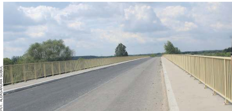
Górna część mostu przeszła już modernizację, teraz przyszła kolej na konstrukcję przeprawy
