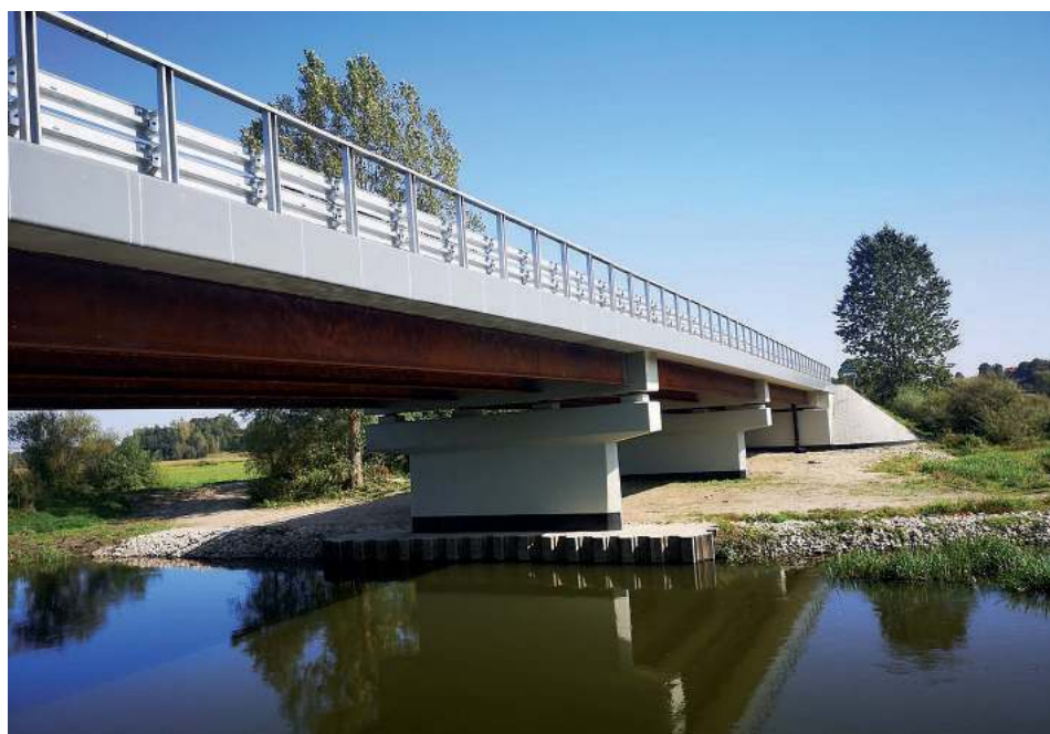
Remont mostu pomiędzy Tarzymiechami i Wirkowicami na terenie gminy Izbica
