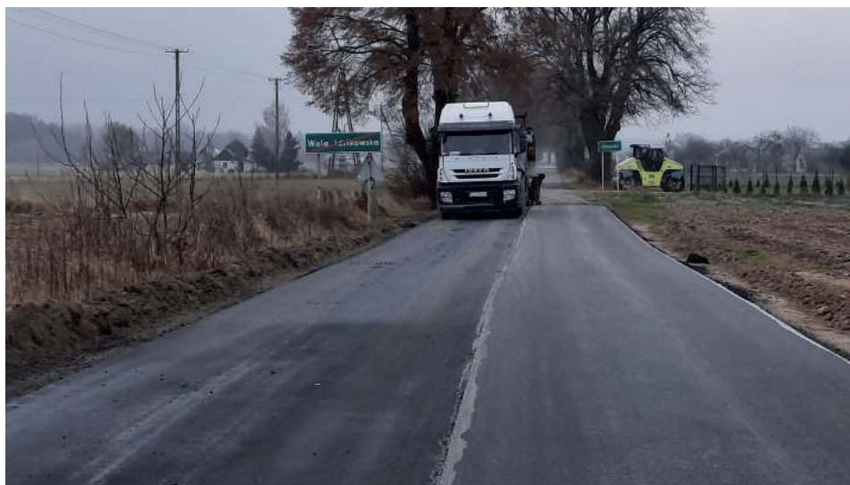
Remont drogi powiatowej w Woli Idzikowskiej, gm. Fajslawice
