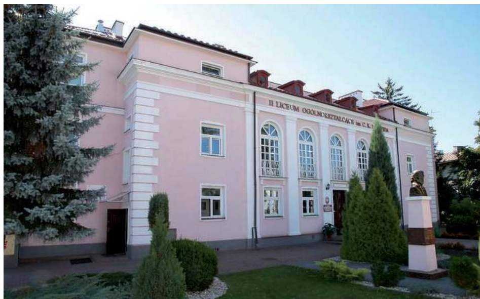
Wyremontowana elewacja II Liceum Ogólnokształcącego im. C.K. Norwida w Krasnymstawie
