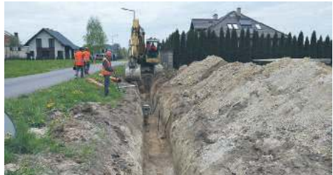
Przebudowa oczyszczalni ścieków w Żmudzi
