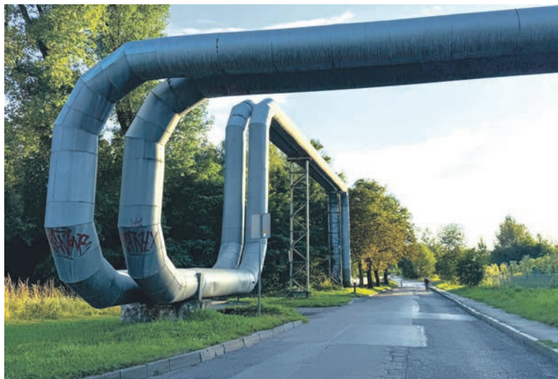
Rurociąg zostanie schowany pod ziemią
