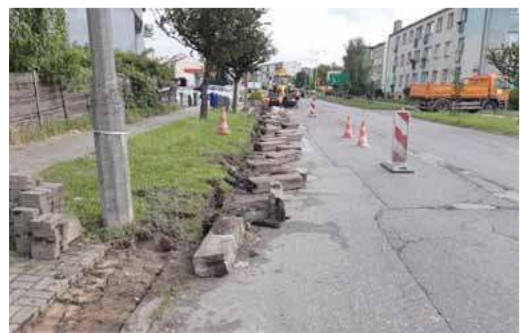
Wymiana krawężników na ul. Grzebskiego
