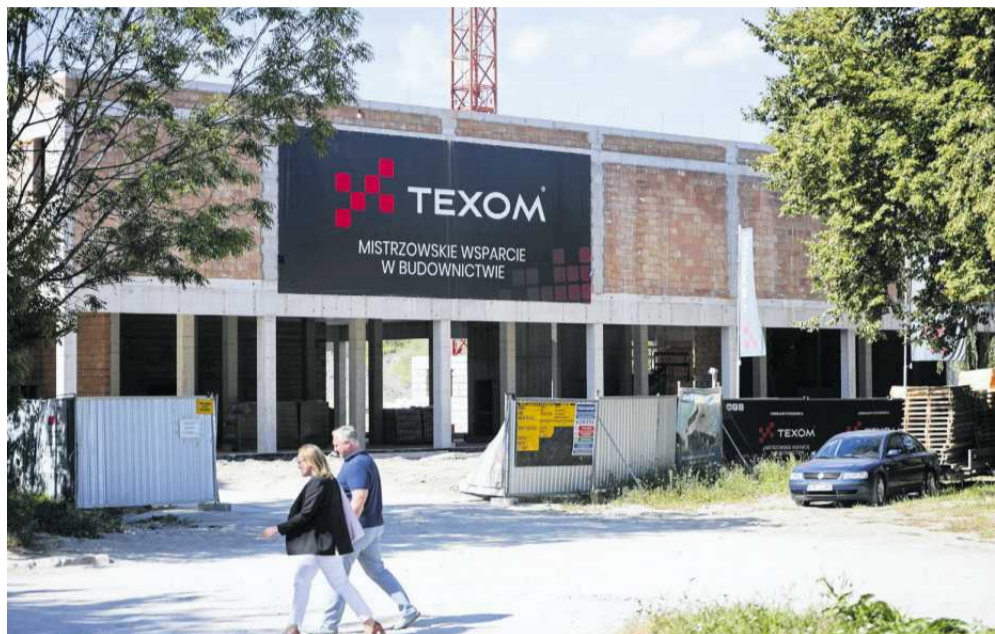
• Przebudowa kompleksu basenów Clepardii FOT. JAKUB WŁÓDEK / AGENCJA WYBORCZA.PL
