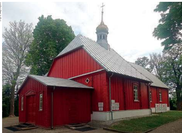
Kościół w Kraszewie, część drewniana
