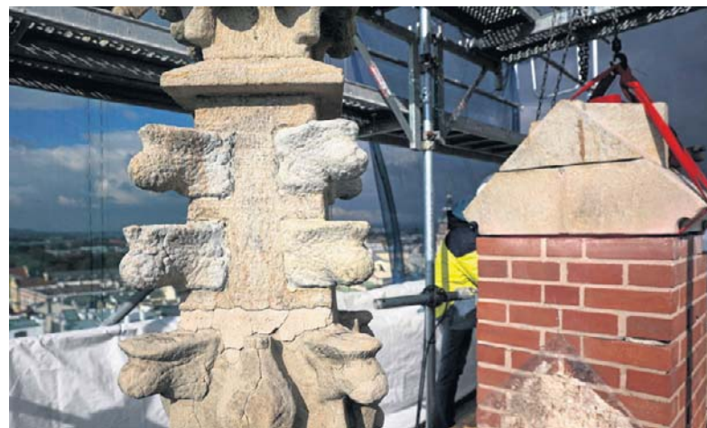
Tak z bliska wygląda sterczyna. Remont elewacji frontowej Bazyliki Świętej Trójcy przy ul. Stolarskiej trwa od wakacji
