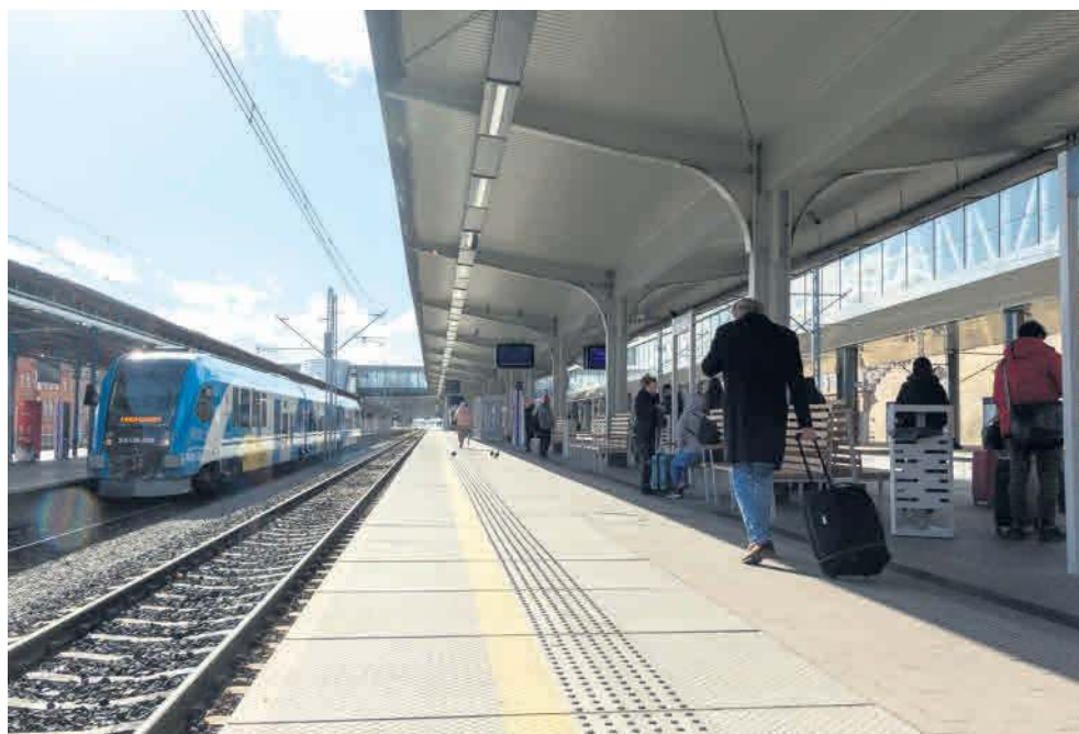
Zmodernizowana stacja Szczecin Główny
