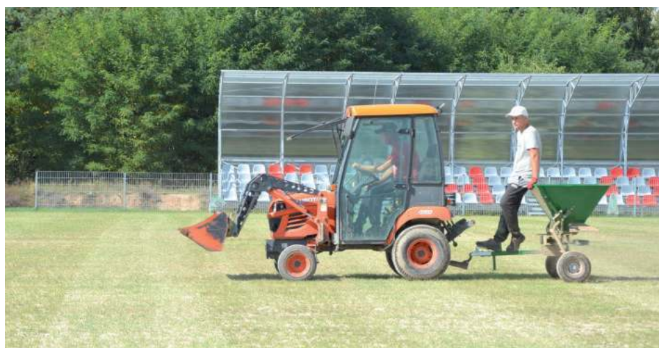
Na nowym boisku w Chodlu usunięta została górna część murawy, wykonane piaskowanie, wzbogacona w niezbędne minerały gleba i dosiana nowa trawa. Ekipę zastaliśmy podczas wykonywania zabiegu piaskowania
