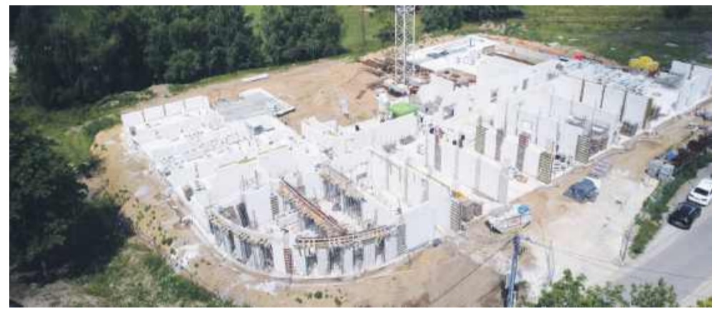
Postęp prac na terenie budowy Szkoły w Wiszni Małej
