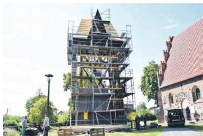
Remont dzwonnicy przy Kościele Parafialnym w Strzeszowie
