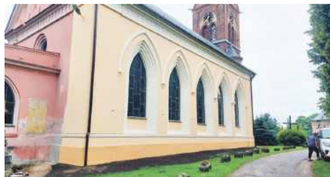
Remont fragmentu elewacji północnej Kościoła Parafialnego w Wysokim Kościele
