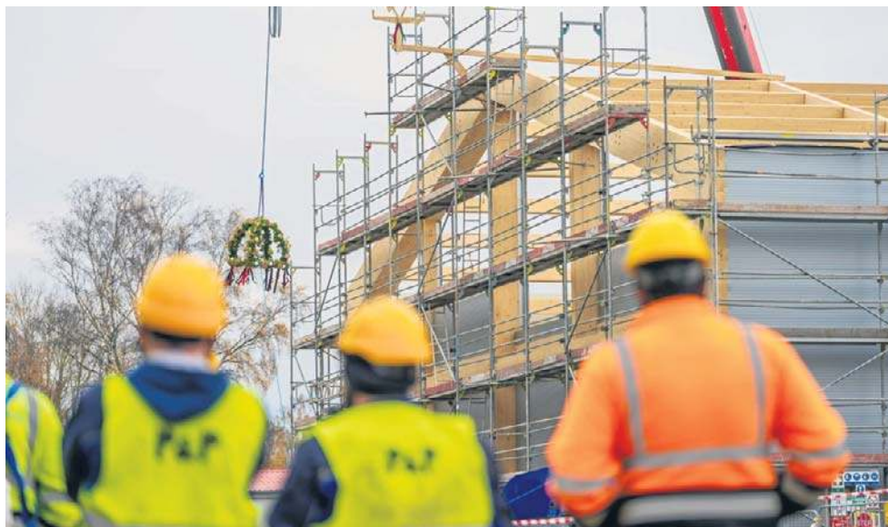
Zawieszenie wiechy symbolicznie zamknęło fazę konstrukcyjną inwestycji
