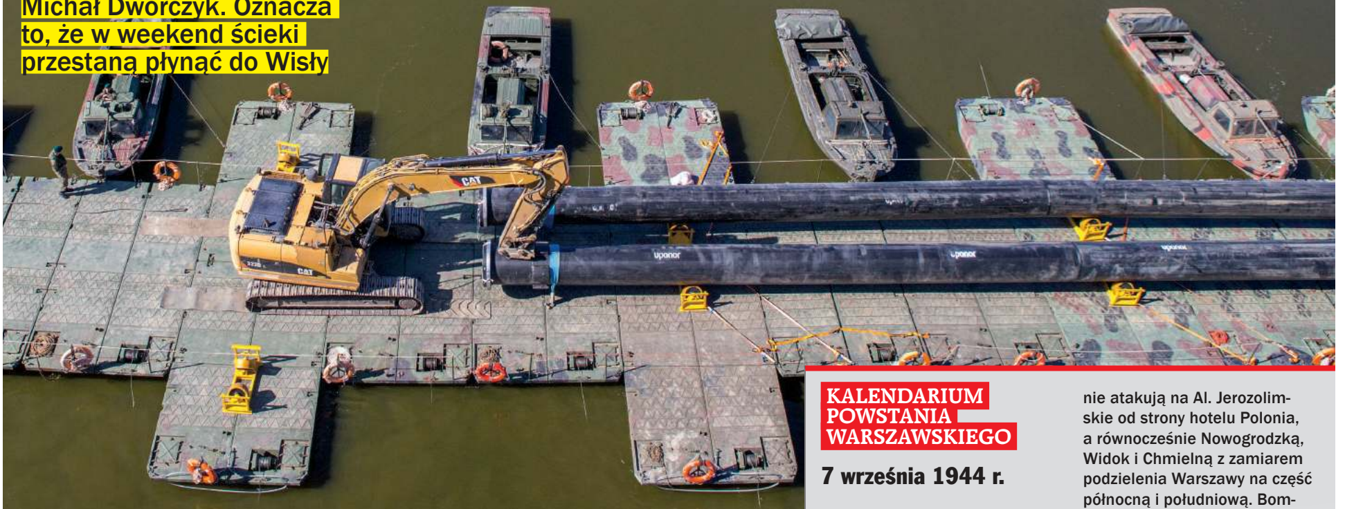
Obie nitki tymczasowego rurociągu były od czwartku jednocześnie wsuwane na most pontonowy | fot. Tomasz Hamrat/Gazeta Polska
