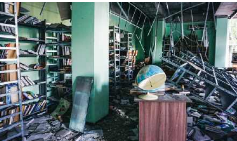
Zniszczona biblioteka w Pokrowsku.
