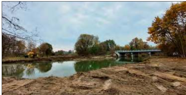
Wojsko dokonało już wycinki drzew, wyrównało teren i usunęło humus.
