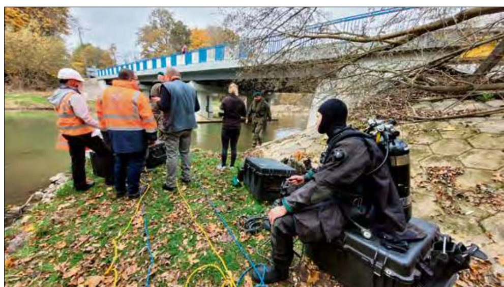
W poniedziałek, 28 października, w miejscu budowy tymczasowej przeprawy pracował Instytut Badawczy Dróg i Mostów z Warszawy.
