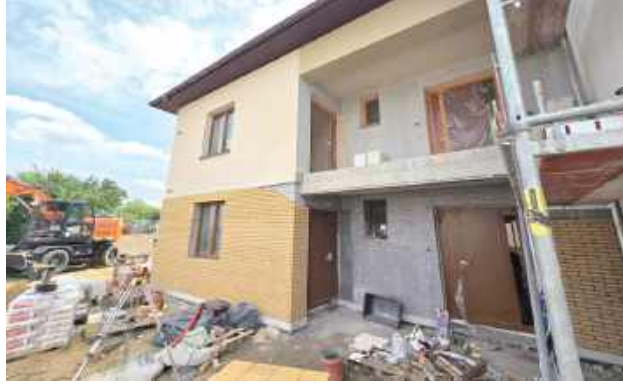
Na zewnątrz budynku układana jest cegła klinkierowa na ścianach parteru
