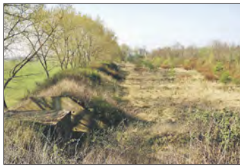
Teren przyszłej inwestycji
