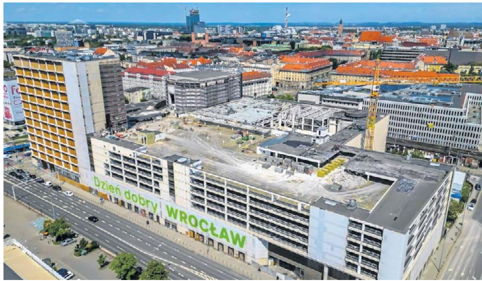
Budynek Arkad wkrótce zostanie całkowicie zasłonięty rusztowaniami
