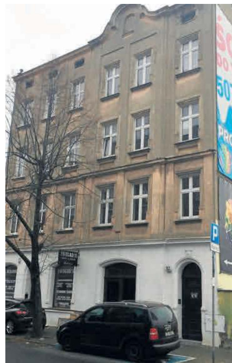
Kamienica przy ulicy Unii Lubelskiej 12 - tu w Bydgoszczy mieszkała Maria Żukowska
