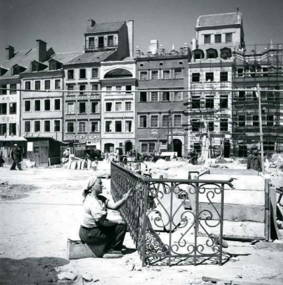
Prace wykończeniowe na Rynku Starego Miasta, 1953 r.
