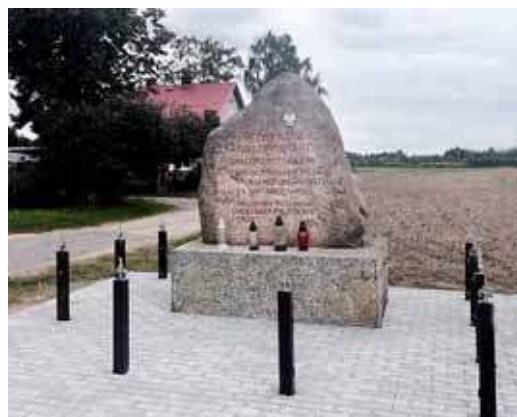
Obelisk z 1992 r. w trakcie renowacji
