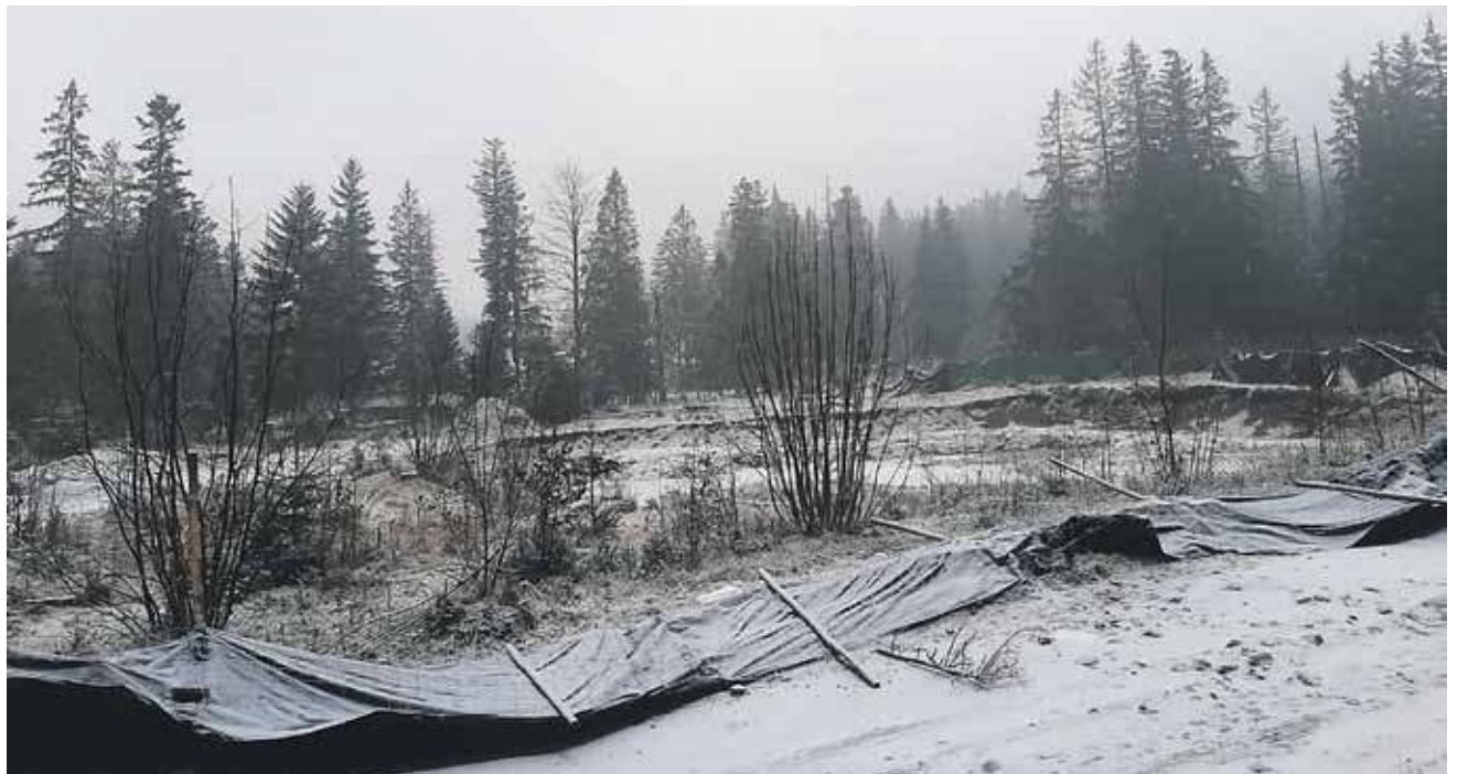
Czas mija, wykopy pod budowę zostały powiększone, halny regularnie niszczy naprawiane ogrodzenie.
