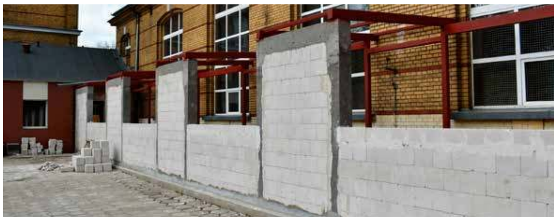
Przy Szkole Podstawowej nr 3 trwa budowa łącznika, który połączy oba budynki szkoły. Uczniowie będą mogli przemieszczać się pomiędzy budynkami bez konieczności wychodzenia na dwór
