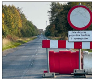
Jak wskazuje mieszkanię gminy Międzyrzec Podlaski, droga od dłuższego czasu jest zamknięta, mimo, że nie są na niej prowadzone roboty budowlane
