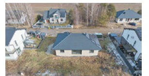
Dom z pompą ciepła i fotowoltaiką - Porosiuki, 604 494 489
