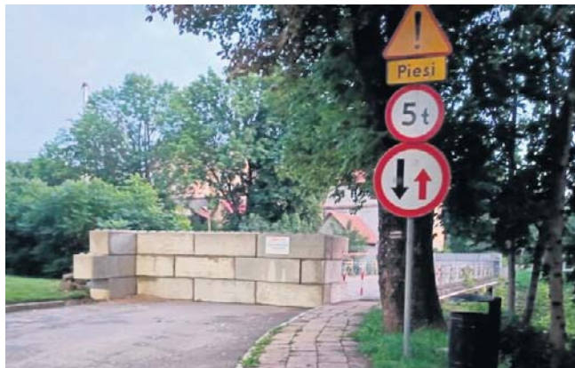
Wiadukt w Połczynie-Zdroju został zamknięty i zamurowany 1 sierpnia
