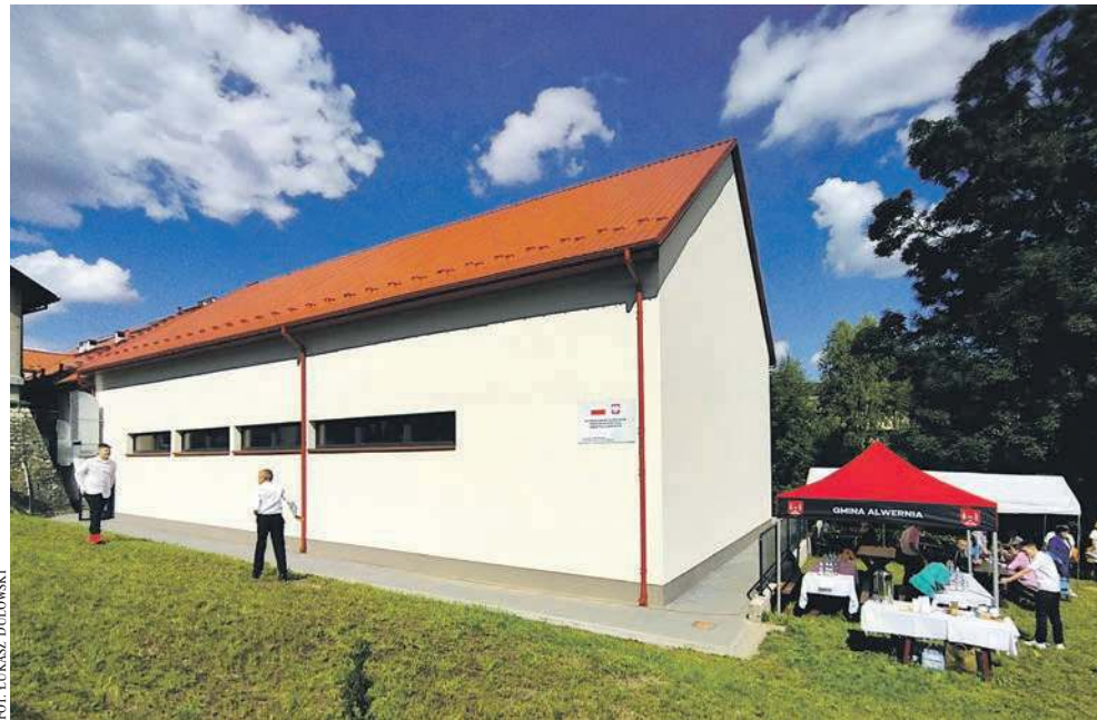
Rozbudowa podstawówki w Grojcu została zakończona z 274-dniową zwłoką
