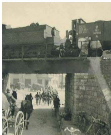
Wiadukt kolejowy nad Krakowską w Chrzanowie. Rok 1939
