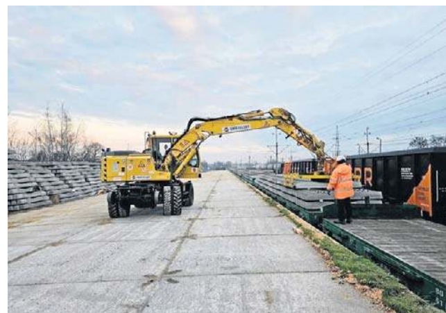
Inwestycja zakłada m.in. przebudowę torów i przejazdów oraz wybudowanie peronów na 13 stacjach i przystankach
