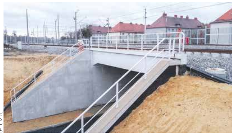
Odnowiony wiadukt nad ul. Dojazd
