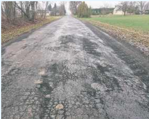
Tak wyglądała droga przed remontem
