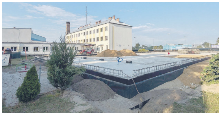
Budowa hali w Trzebieszowie Drugim fot. Andrzej Hryciuk
