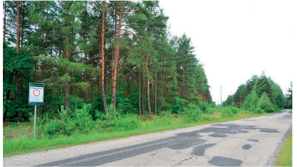
Sporne miejsce znajduje się przy drodze Czyżówka- Płoki
