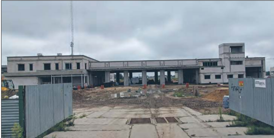
W 2025 roku na budowę strażnicy PSP rada powiatu przeznaczyła 9 mln zł. Zakończenie I etapu inwestycji przewidziano na koniec lutego bieżącego roku
