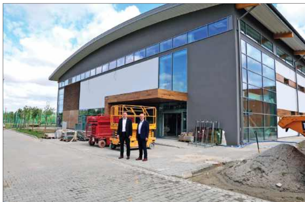
Krzysztof Szostak, I Zastępca Prezydenta i poseł Fryderyk Kapinos na budowie Hali przy ZSO w Mielcu.
