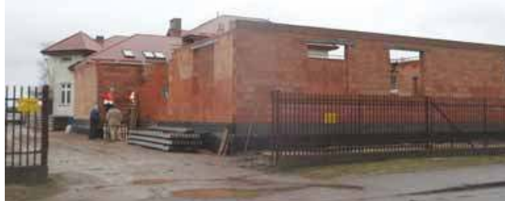
Rozbudowa obiektu SP w Dzierzgowie
