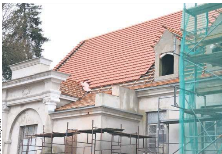
Prace modernizacyjne przy przebudowie zabytkowego dworca w Sierpcu prowadzone są od lipca ubiegłego roku
