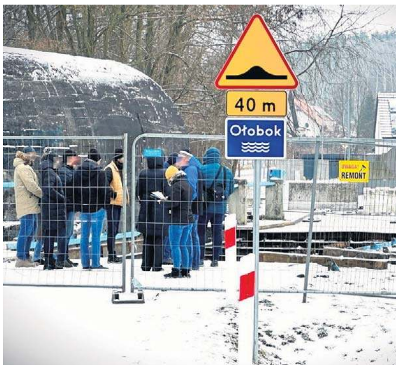
Most przesuwny nr K602 wraz ze schronem z jazem nr 602 w Ołoboku decyzją z 6 grudnia 2022 roku został wpisany do rejestru zabytków
