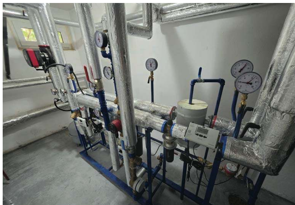
Zakończona wymiana węzła cieplnego przy ul. Gdańskiej ma pomóc w redukcji kosztów ogrzewania budynków
