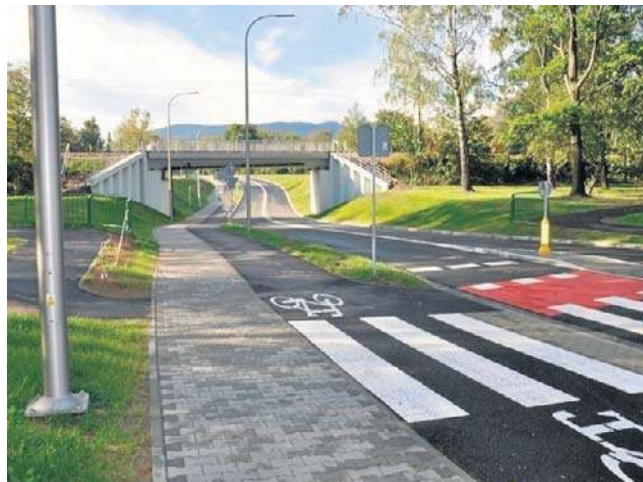
Obwodnica Kęt powstaje etapami. W ub. roku zakończono odcinek między ulicami Spacerową a Sobieskiego
