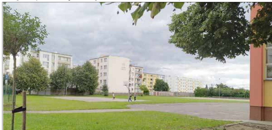
Hala sportowa ma zostać wybudowana pomiędzy budynkiem SP nr 2 a zabudowaniami mieszkalnymi widocznymi w tle zdjęcia
