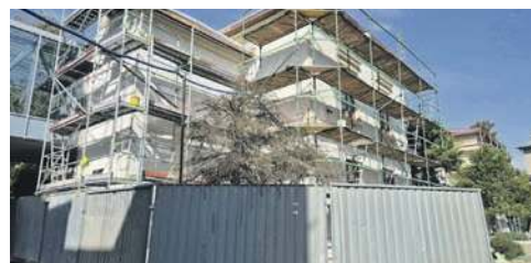
Trwają jeszcze prace przy remoncie elewacji LO w Krzeszowicach
