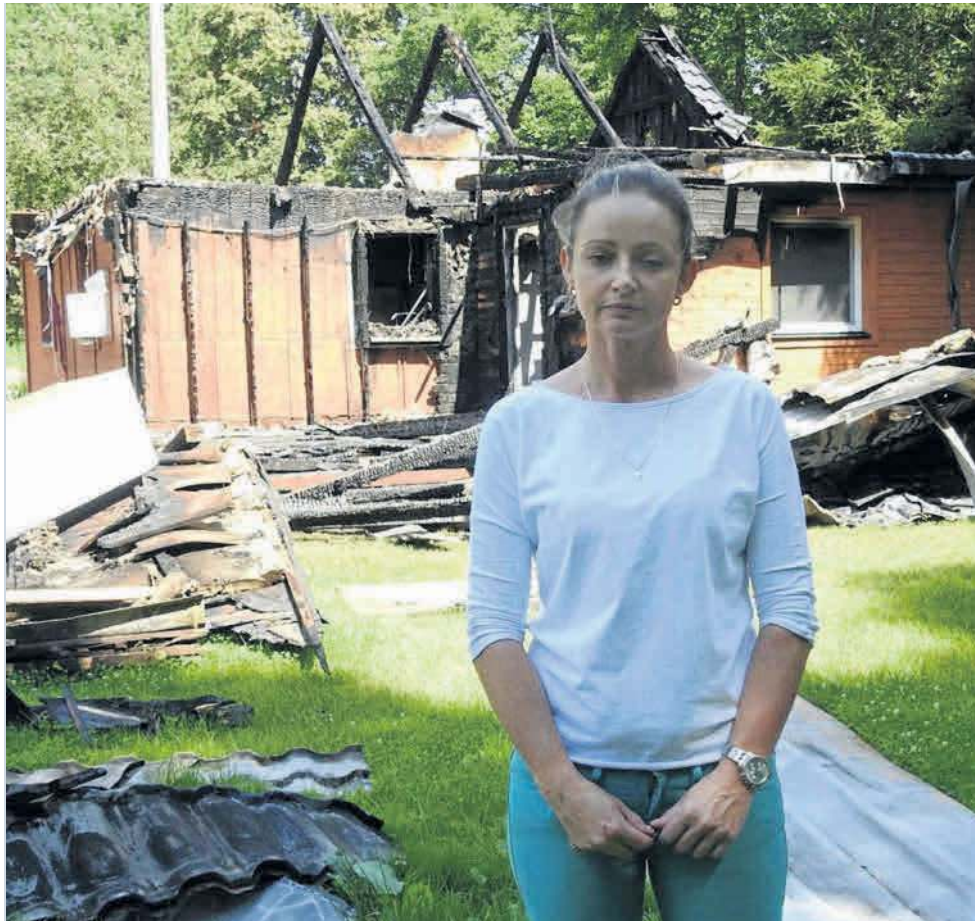
Już wiadomo, że drewnianego domu nie da się odbudować. Beata Zacharewicz chce postawić obok niego nowy, tym razem murowany. Uda się tylko z pomocą ludzi dobrej woli
